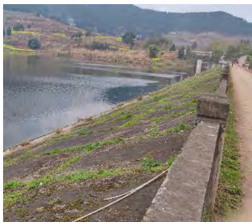
大坝坝顶和迎水面
