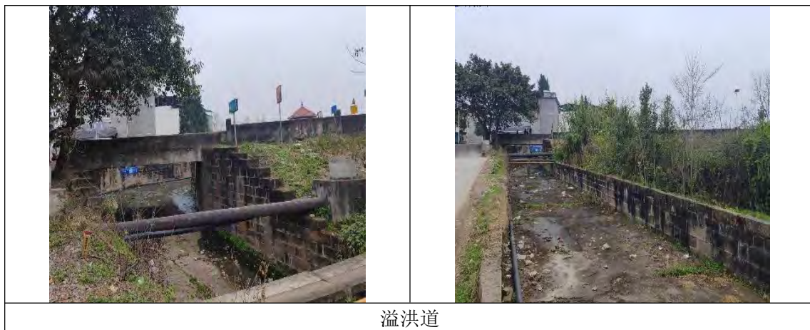
图 1.1-10 箱石水库溢洪道现状图
