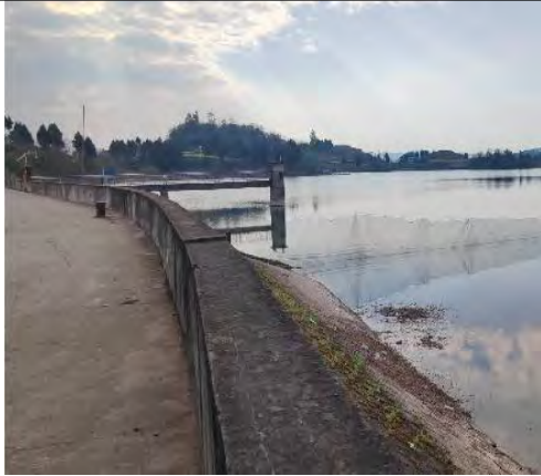
大坝坝顶和迎水面
