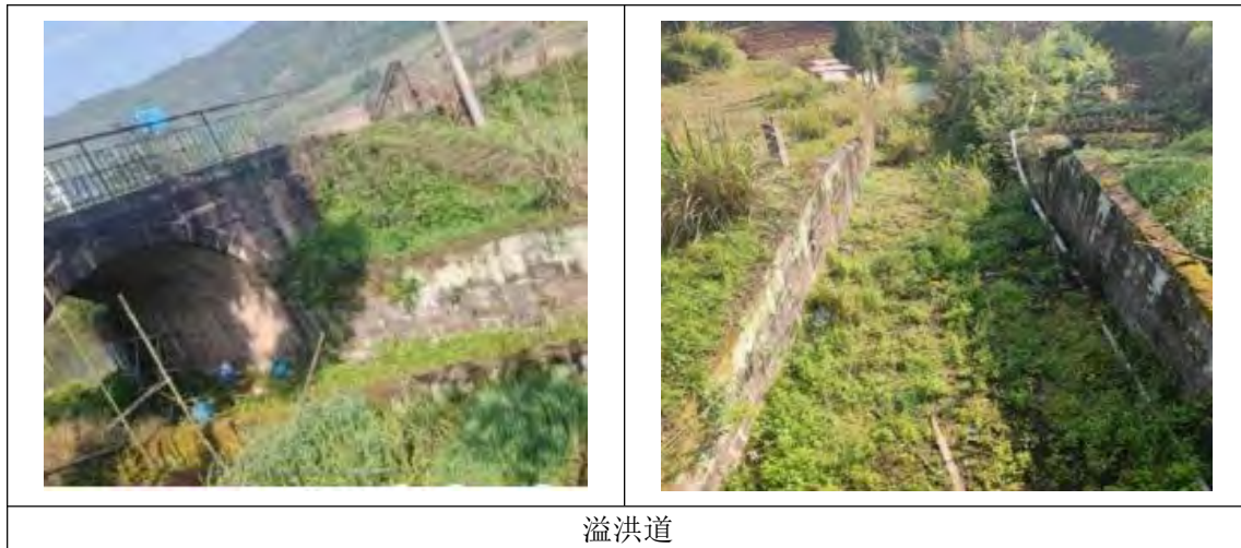
图 1.1-14 张家湾溢洪道现状图
