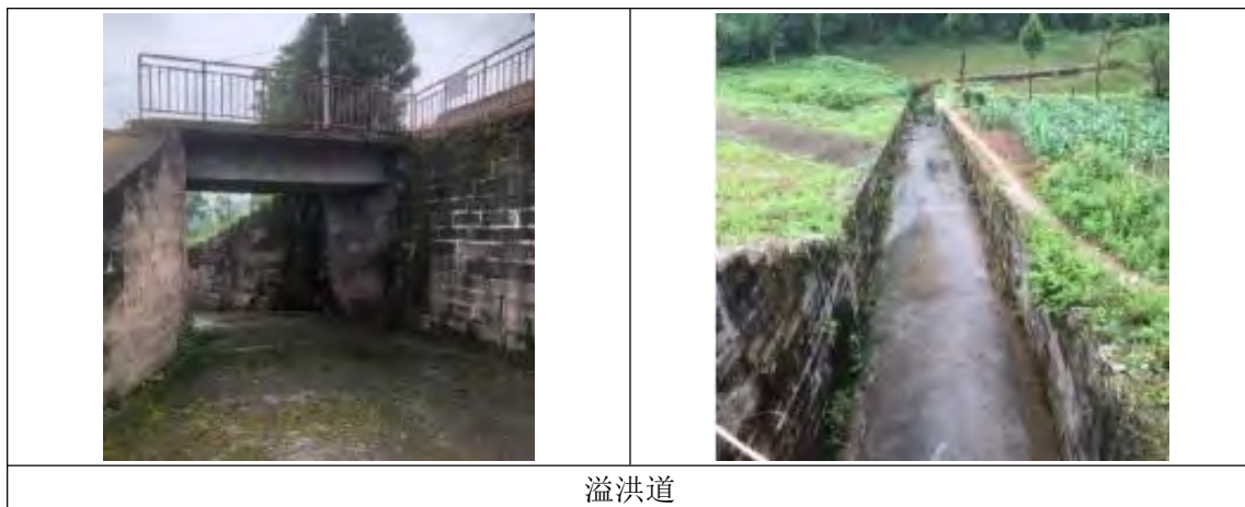
图 1.1-4 聂家坝水库溢洪道现状图
