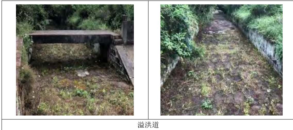
图 1.1-6 三八水库溢洪道现状图
