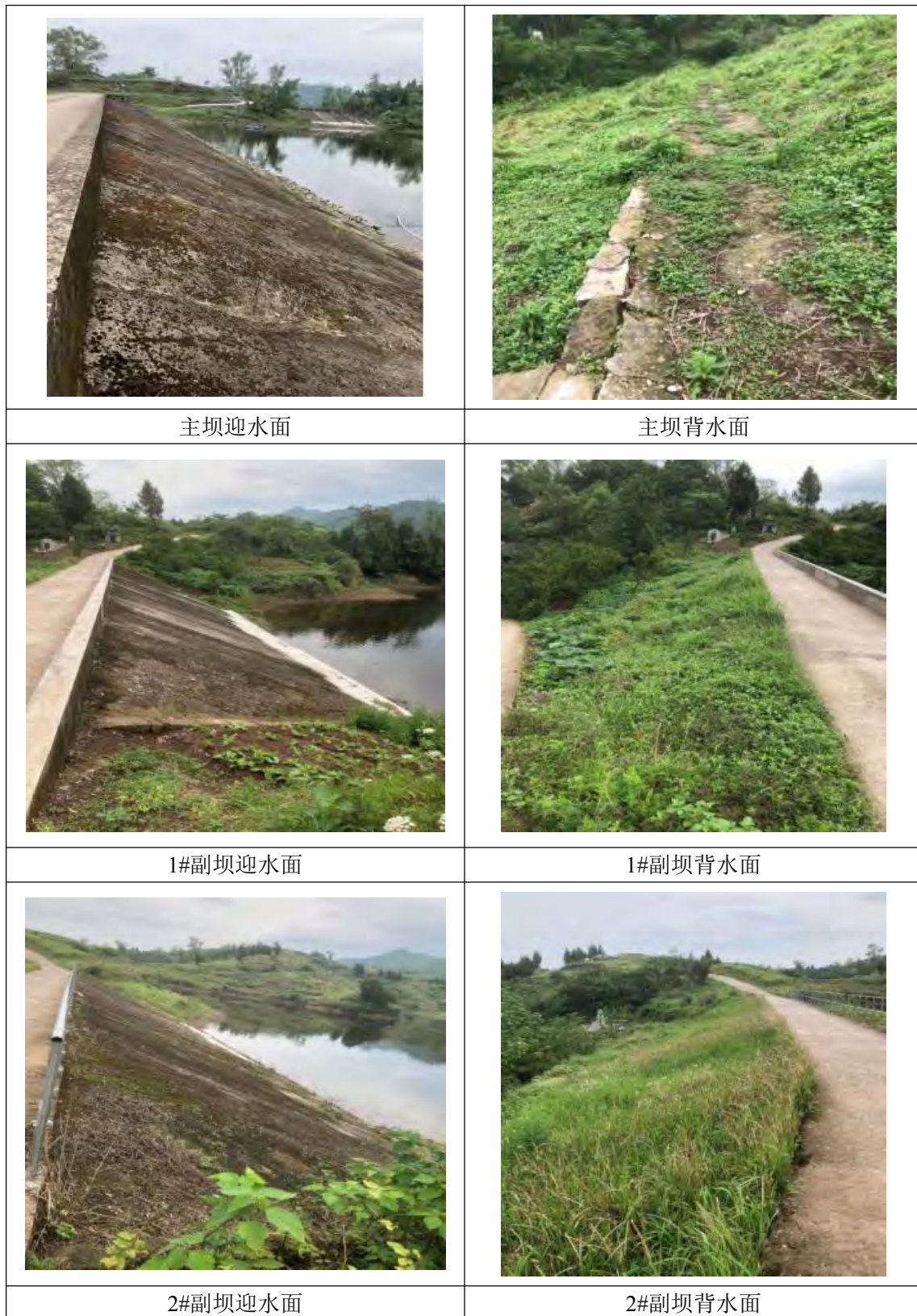
图 1.1-1 黄家沟水库大坝现状图
