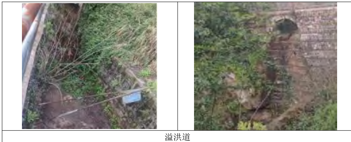
图 1.1-8 锁口丘水库溢洪道现状图
