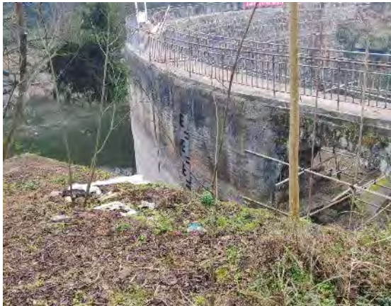
大坝迎水面及坝顶
