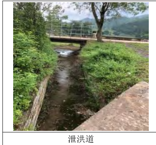
图 1.1-2 黄家沟水库溢洪道现状图
