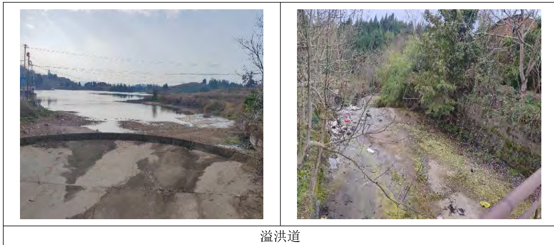
图 1.1-12 新河堰水库溢洪道现状图
