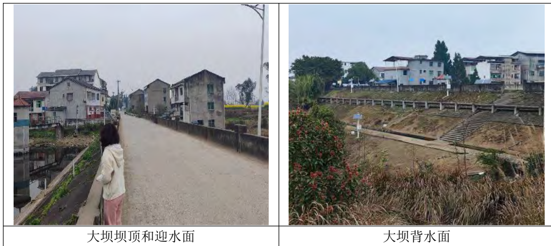
图 1.1-9 箱石水库大坝现状图
