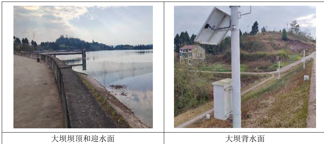
图 1.1-11 新河堰水库大坝现状图
